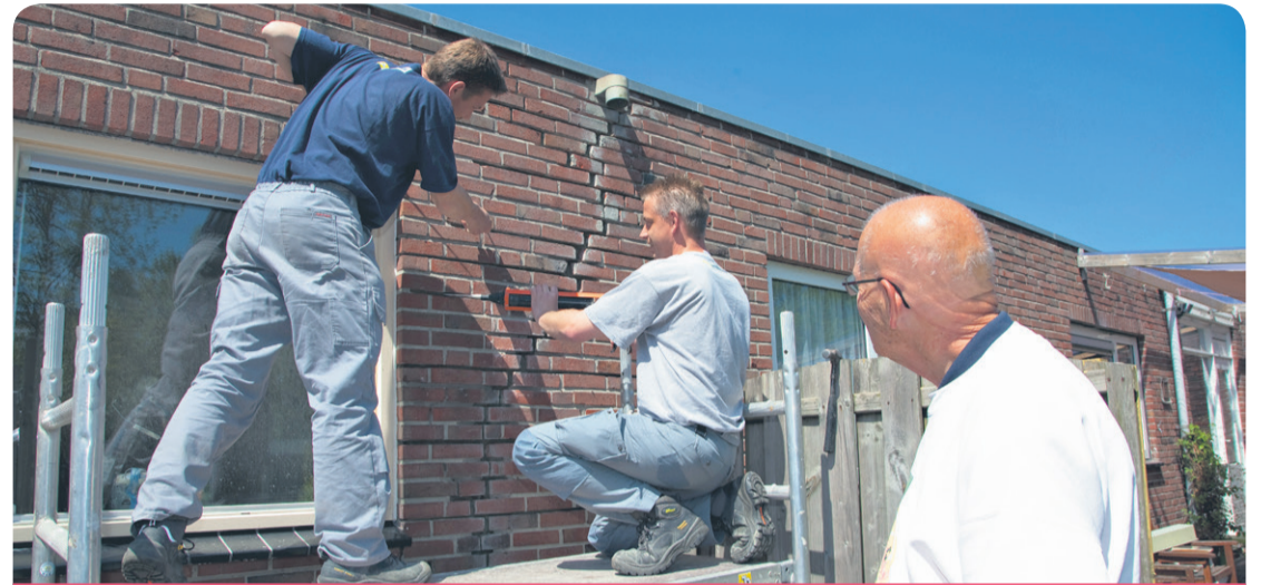
Jans Warringa kijkt hoe Sipke Wouda en Klaas de Haan de muurschade aan zijn woning herstellen.
